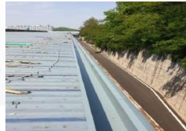
- 홈통 점검 및 보강 - 실리콘 처리 및 실링작업
