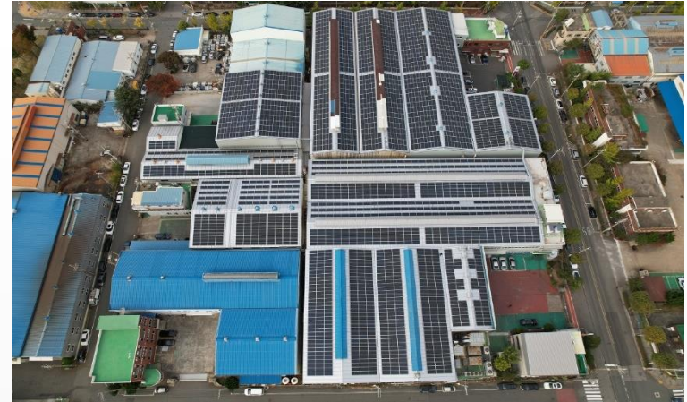
● 터보파워텍(1.23MW) - 부산 강서구
